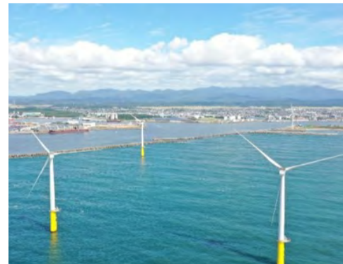
▲ 秋田港洋上風力発電所
