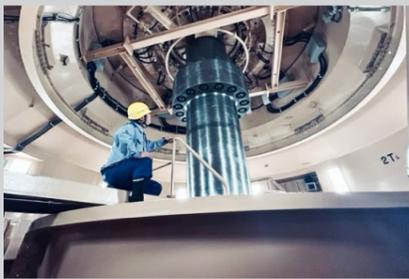
■水車軸と発電機下部の点検の様子
