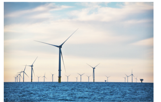
■ ③トライトンノール洋上風力発電所
