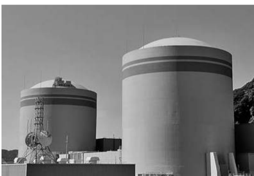
▲手前から高浜発電所1、2号機（写真②）
