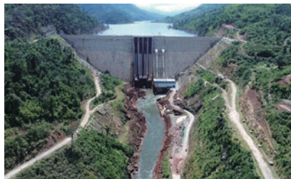
ナムニアップ1発電所
