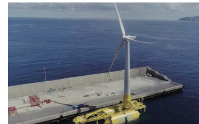
DemoSATHプロジェクト(浮体式)
