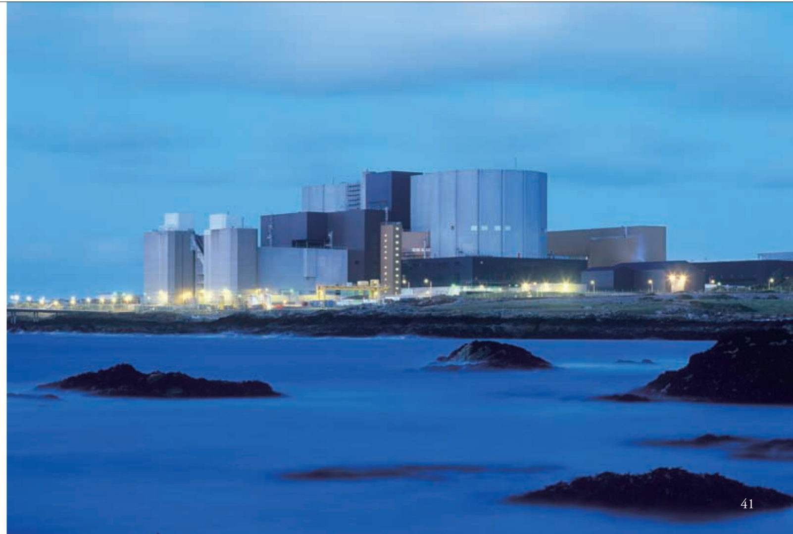
運転開始後40年以上、現在、イギリスで最も古いウィルファ原子力発電所 ©Martin Bond/Science Photo Library/PPS通信社
