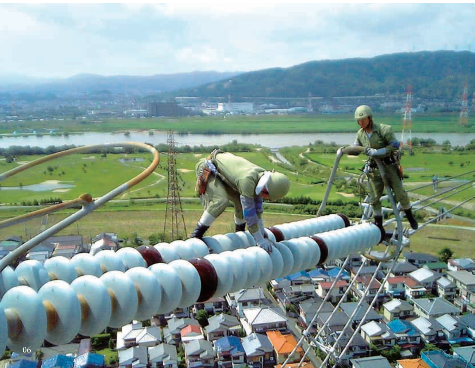
発電から送配電まで一貫して担ってきた電力会社(送電線メンテナンス)
