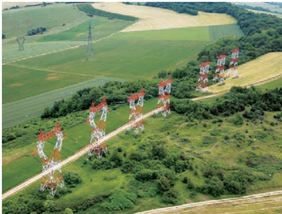
フランスの送電線 ©RTE
