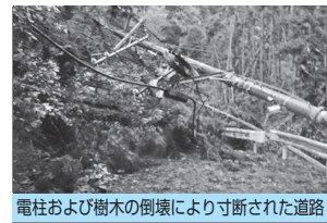
電柱および樹木の倒壊により寸断された道路
