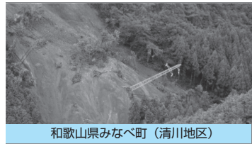
和歌山県みなべ町（清川地区）
