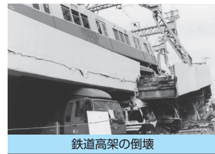
鉄道高架の倒壊
