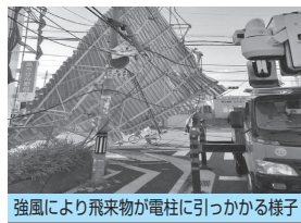
強風により飛来物が電柱に引っかかる様子
