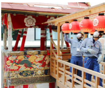
祇園祭山鉦の配電検査
