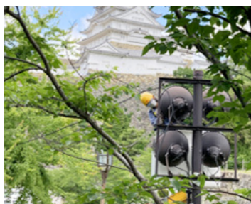
高所作業車を活用した姫路城の照明清掃
