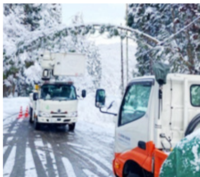
雪害における電柱折損の復旧作業
