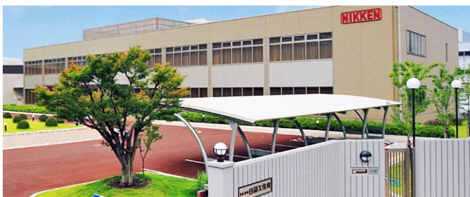
日研工作所様の外観と太陽光発電パネル
