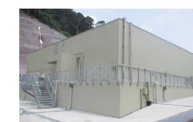
緊急時対策所
