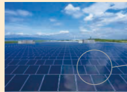
太陽光パネル
