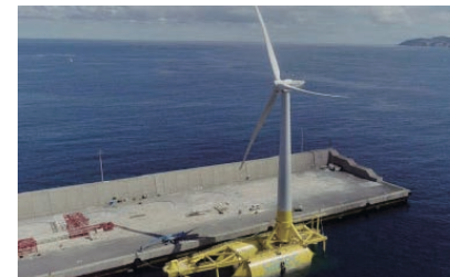
DemoSATHプロジェクト(浮体式)
