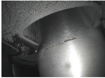
(A-SG第3管支持板のきずの状況)
