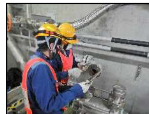
仮設中圧ポンプ接続訓練
