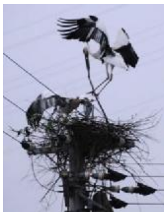
電柱に営巣している様子
