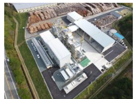
朝来バイオマス発電所
