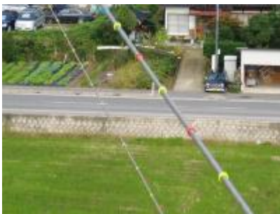
電線のカラーリング
