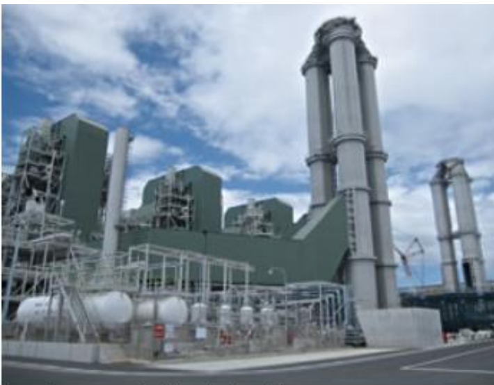
姫路第二発電所設備更新後の外観
