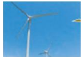
田原4区風力発電所
