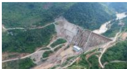
主発電所・主ダム
