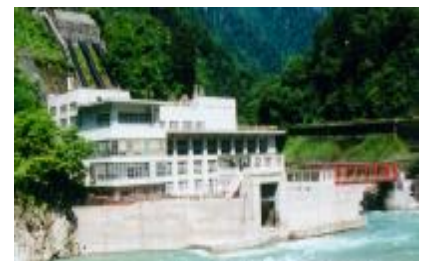
黒部川第二発電所
