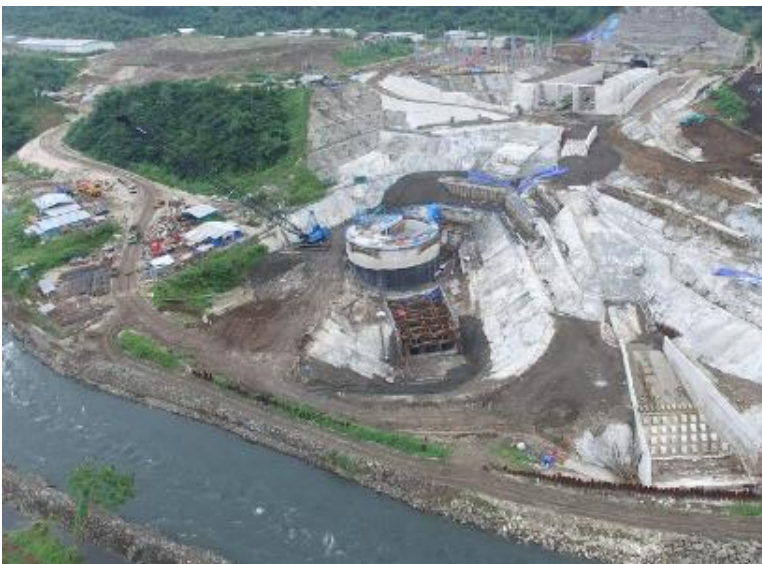
発電所エリアの状況
