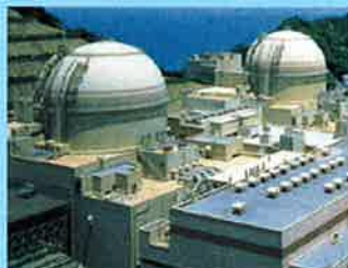
大飯発電所 (471万kW、原子力)
