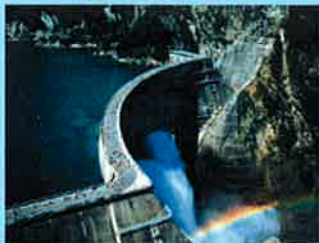
黒部川第四発電所 (33.5万kW、水力)
