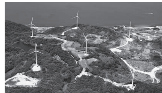
淡路風力発電所
