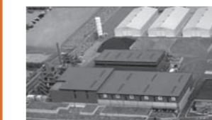
浄化プラント全景
