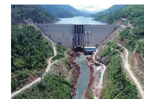
2014年 ナムニアップ着工 ラオスに第二のくろよんとも呼べる大規模な水力発電ダムの建設を開始
