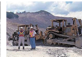
1998年 「サンロケプロジェクト」へ参画 国内電力会社として初めて海外発電事業へ参画し、現地での建設工事に協力
