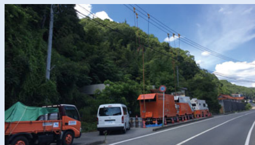
配電線の復旧作業をおこなう様子
