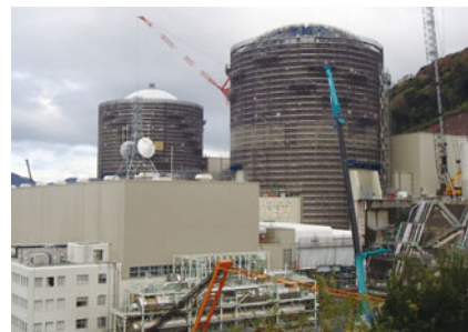
高浜発電所1、2号機 原子炉格納容器上部 遮へい設置工事
