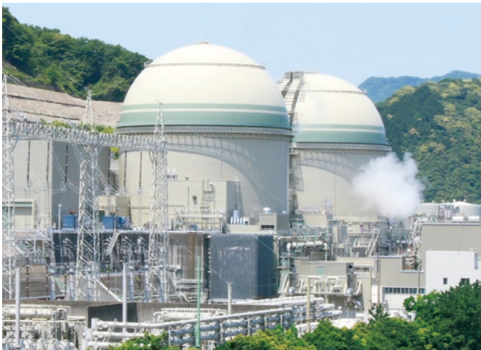
運転を再開した高浜発電所3、4号機
