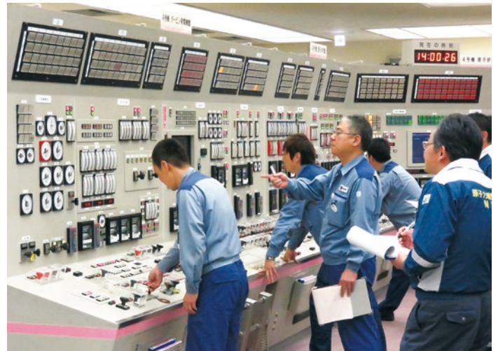
高浜発電所4号機の並列操作をする運転員
