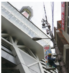
通天閣の電気設備点検
