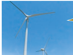
田原4区風力発電所
