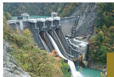
出し平発電所
