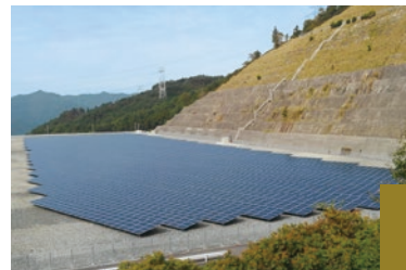
山崎太陽光発電所
