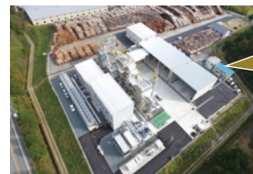
朝来バイオマス発電所
