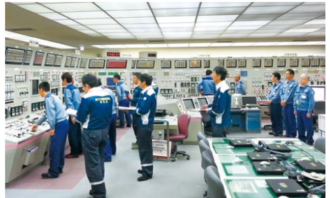
発電を開始した際の中央制御室の様子
