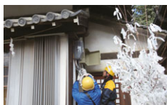
住吉神社での電気設備点検 (兵庫県明石市)
