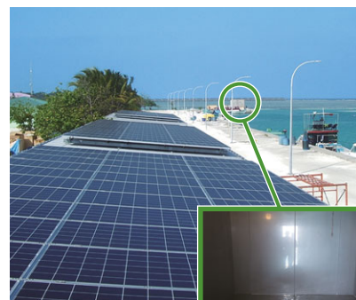
建設した太陽光発電設備 と製氷機
