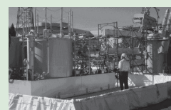
移動式溶剤洗浄装置による 無害化処理状況
