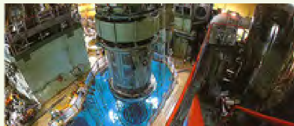
美浜発電所 原子炉圧力容器上蓋吊り上げ作業
