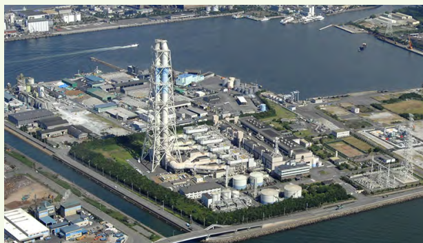
姫路第一発電所
