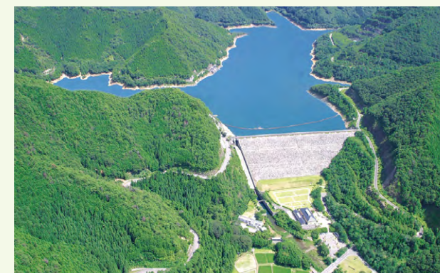
奥多々良木発電所下部ダム(多々良木ダム)
