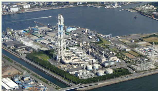
姫路第一発電所
