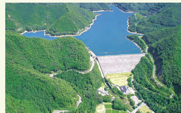
奥多々良木発電所下部ダム（多々良木ダム）
