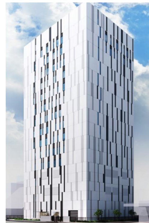
曽根崎データセンター(OC1) ※2026年1月運用開始
