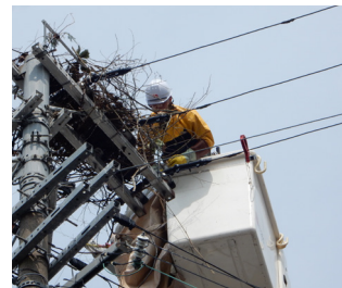
電柱の状況を確認する様子
