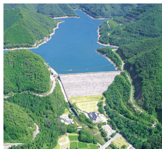
奥多々良木発電所下部ダム(多々良木ダム)
