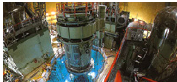
美浜発電所 原子炉圧力容器上蓋吊上げ作業
