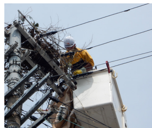
電柱の状況を確認する様子
