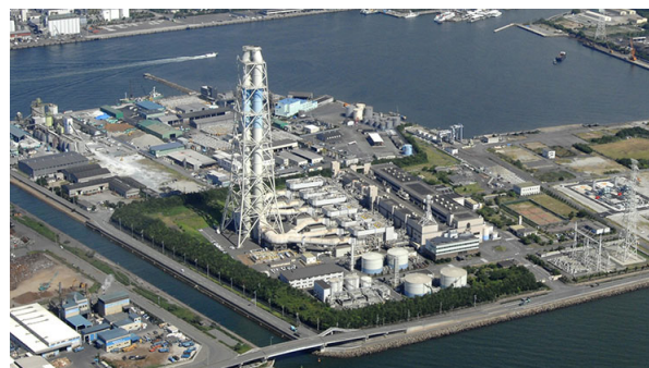
姫路第一発電所
