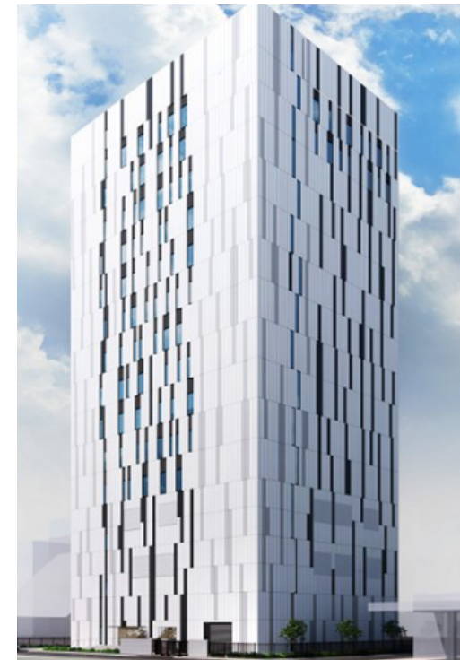
曽根崎データセンター(OC1) ※2026年1月運用開始
