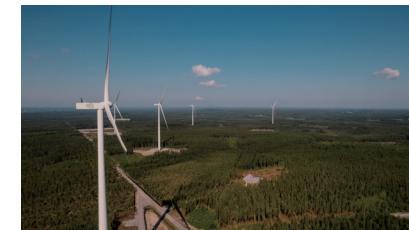
アラヤルヴィ 陸上風力発電所
