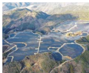
【太陽光】 播州メガソーラー発電所
