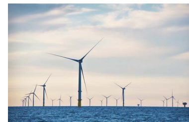
トライトンノール洋上風力発電所
