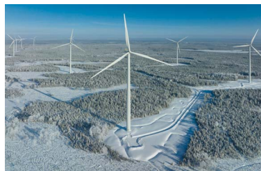
ピーパリンマキ陸上風力発電所
