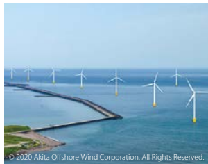
【洋上風力】秋田港及び能代港 (提供:秋田洋上風力発電株式会社)
