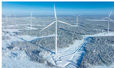
ピーパリンマキ陸上風力発電所
