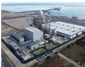
【バイオマス】 かんだバイオマス発電所
