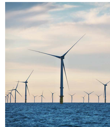
トライトンノール洋上風力発電所
