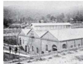
第1期建物 (操業開始当時)
