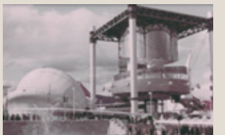
電力館(左側:水上劇場、右側:本館)
