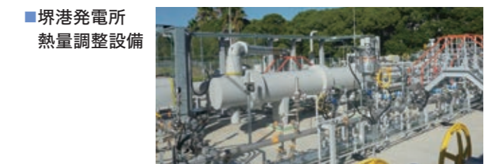
■堺港発電所 熱量調整設備
