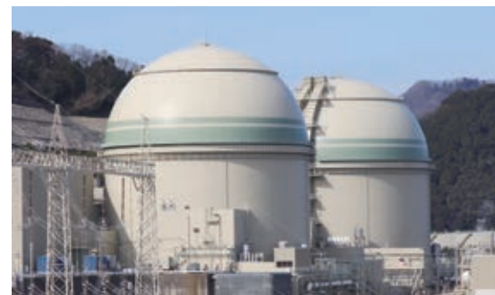
高浜発電所3、4号機
