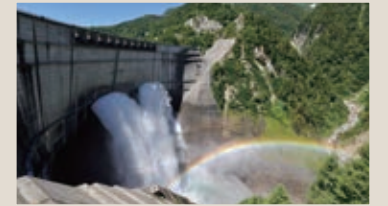
完成した「くらよん」が関西に電気を送る
