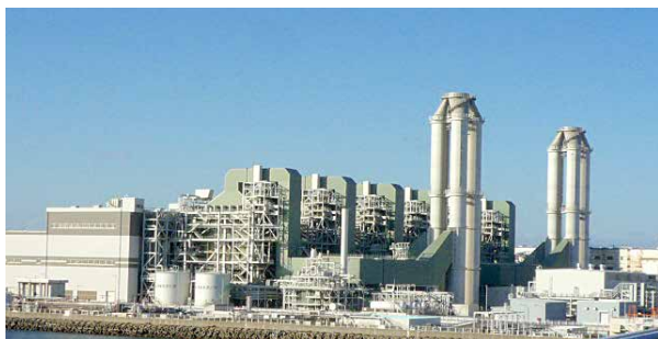
姫路第二発電所
