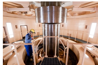
大河内発電所 巡視点検の様子
