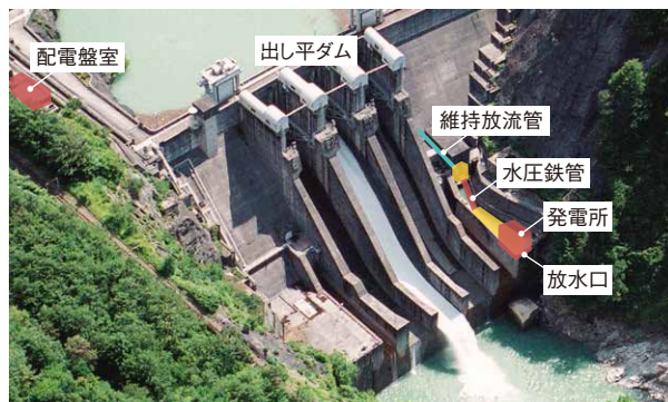
出し平発電所(建設中)のイメージ図
