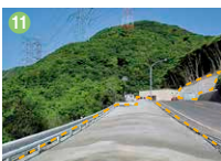
防火帯(樹木伐採箇所)
