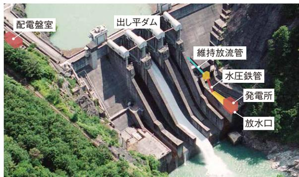
出し平発電所(建設中)のイメージ図
