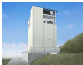
外観イメージ(大飯発電所)
