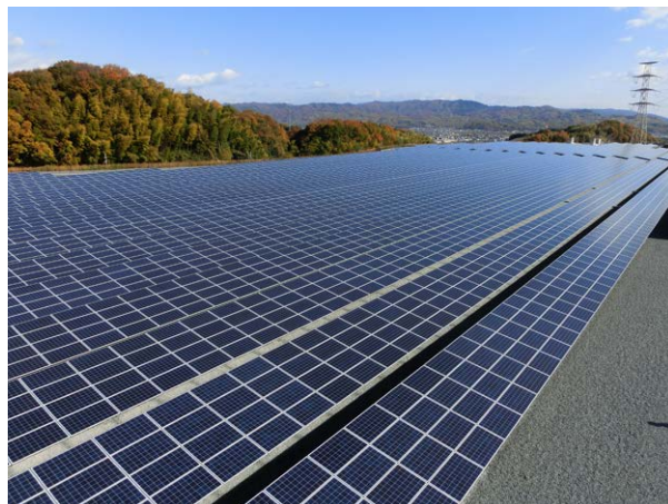
けいはんな太陽光発電所
