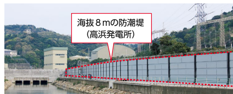
防潮堤の設置
