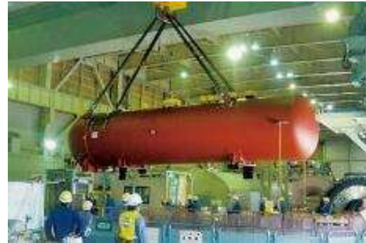
高圧給水加熱器の取替え
