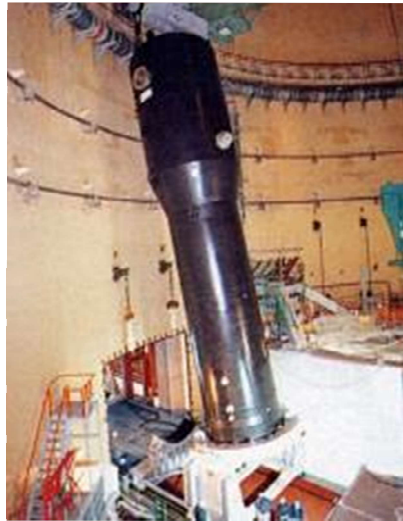
蒸気発生器の取替え
