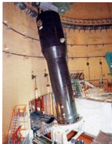
蒸気発生器の取替え
