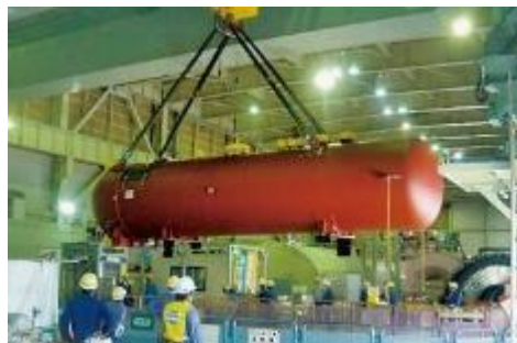
高圧給水加熱器の取替え
