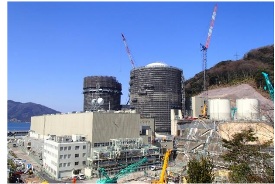
- 高浜1、2号機のトップドーム工事 -
