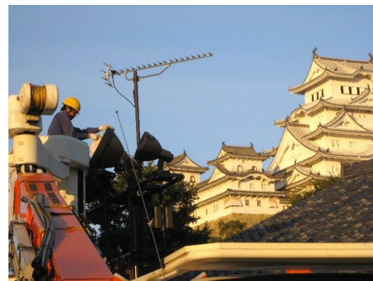
- 姫路城の電気設備の清掃 -
