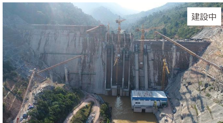
- ナムニアップ発電所の主ダム(ラオス) -
