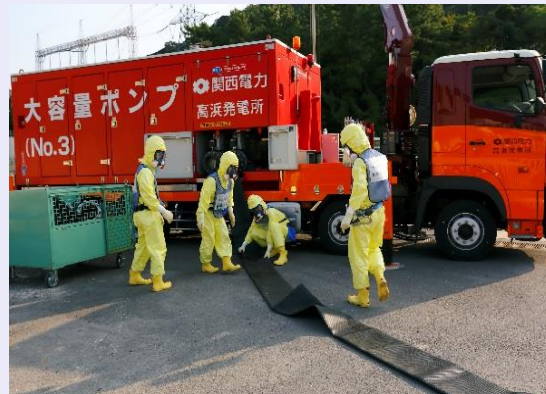
<大容量ポンプによる冷却訓練>
