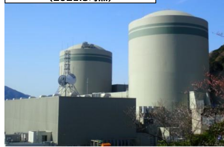
格納容器上部遮蔽設置工事の状況 (2021.3時点)
