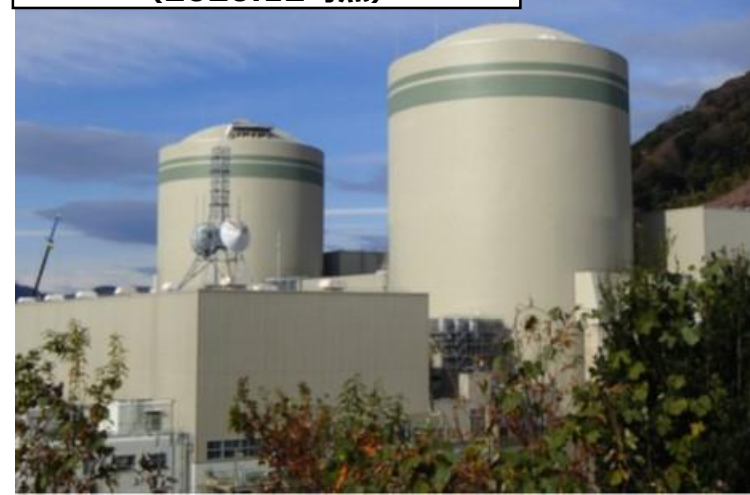
格納容器上部遮蔽設置工事の状況 (2020.12時点)
