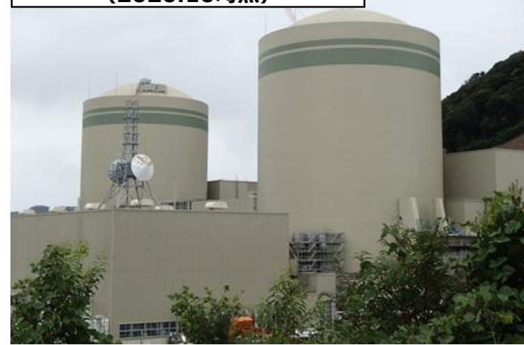
格納容器上部遮蔽設置工事の状況 (2020.10時点)
